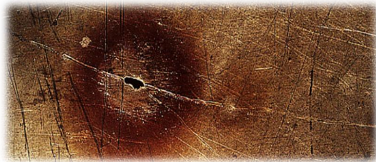
Figure 5 : Corrosion par piqûres sur la paroi d'une plaque [5]
