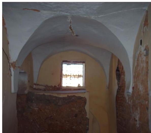
*Fig.V.9 des défects d'enduit sur une très grande partie des murs*
