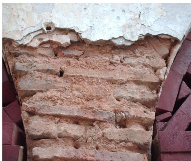
*Fig.V.15 décollement de la couche d'enduit faite à base de ciment*
