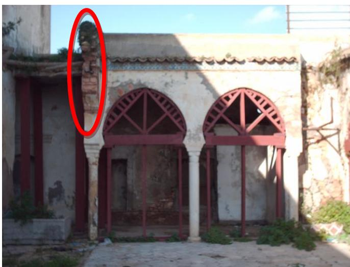
*Fig.V.8 effondrement du mur de soutènement du portique à l'intérieur de la villa B*
