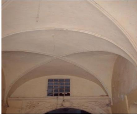
*Fig.V.3 Coupoles en maçonneries avec un enduit*
