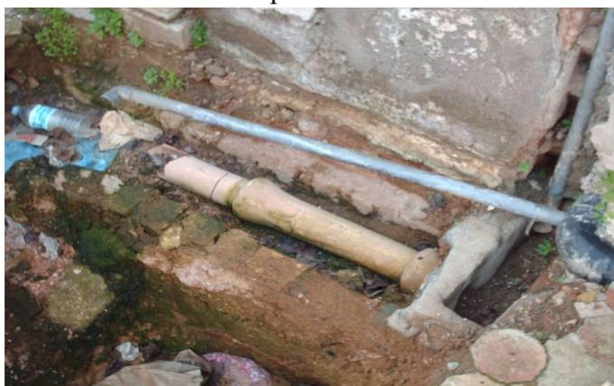
*Fig.V.16 canalisation rompue, ainsi que la tuvauterie*
