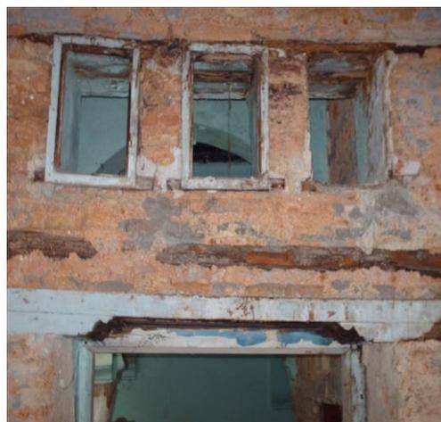
*Fig.V.18 trace d'humidité sur les murs intérieurs dont l'effet est aggravé par l'absence d'enduit*
