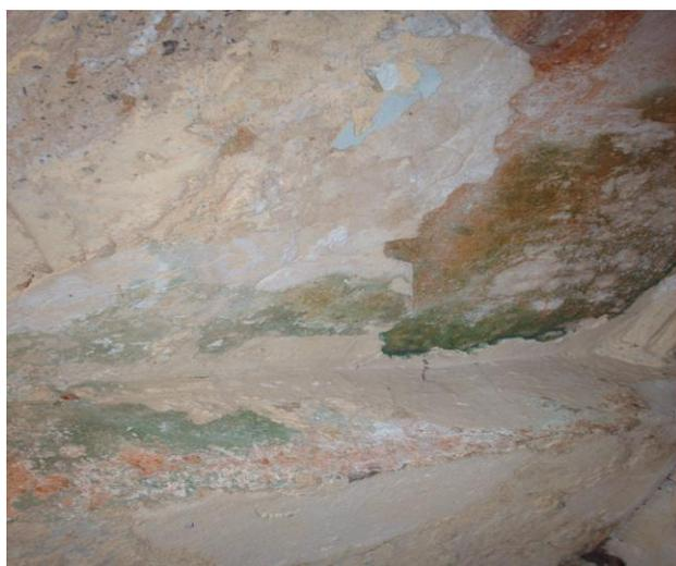
*Fig.V.14 développement de lichens sur le parement*
