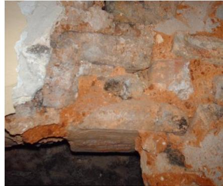
*Fig.V.4 système constructif, utilisant une brique de terre cuite et un mortier de chaux et de terre*
