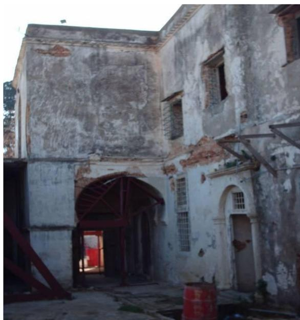
*Fig.V.17 trace d'humidité sur les murs extérieurs*
