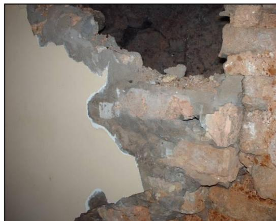
*Fig.V.13 utilisation d'un mortier à base de ciment pour le jointement et l'enduit*
