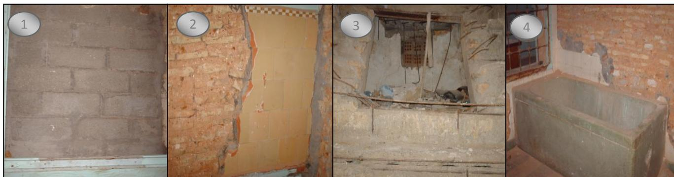
*Fig.V.11 différents dégâts causés par l'occupation et la modification des lieux*
