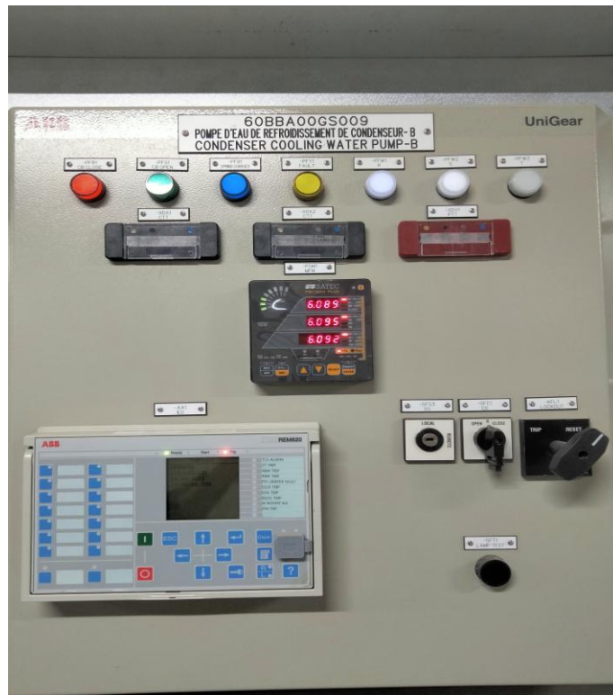
FigureII.15 Disjoncteur de la pompe
