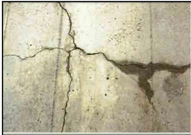
**Figure I.15** - Fissuration en étoile de plusieurs millimètres d'ouverture due à la réaction alcali-granulat, [14].
