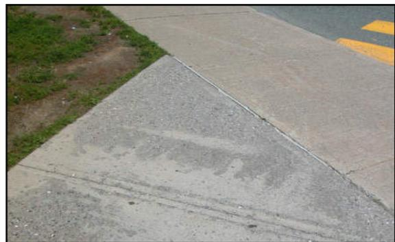
Figure I.12 - Écaillage de la surface, [8].
