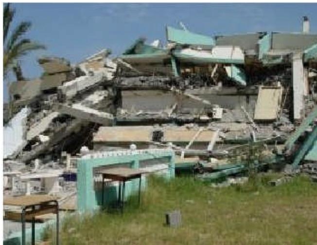
**Figure II.2** - Bâtiments effondrés lors du séisme de Boumerdès 2003, [12].
