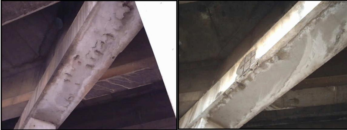
**Figure I.3** : Insuffisance d'enrobage (front de mer Oran), [4].
