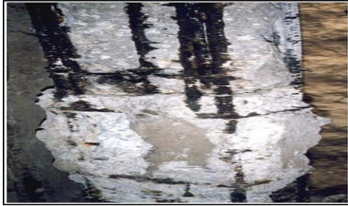
**Figure II.3** - Corrosion accélérée des amorces poteaux, [11].
