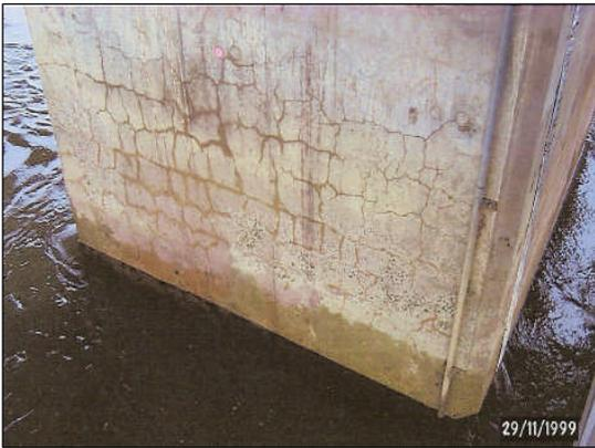
**Figure I.22** - Echelle macroscopique, réseau de fissures, [12].
