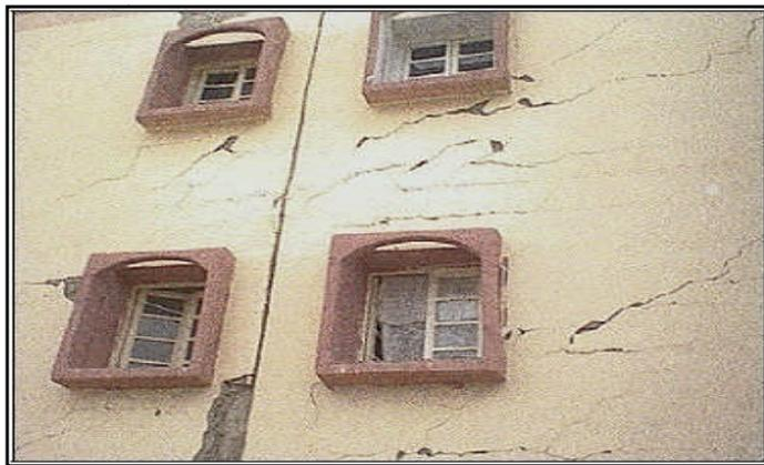
**Figure II.4** - Fissures à l'extérieur dues au tassement différentiel, [11].
