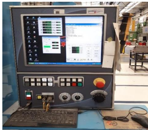
Figure 1.22 : Console centrale de la machine HP115
