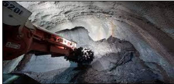
Figure 1-6: Machine à attaque ponctuelle
