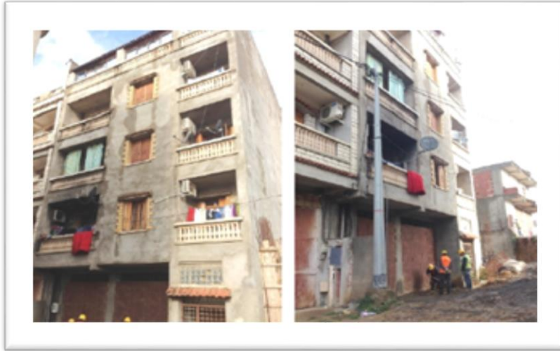
Figure 5-2 : Façade de Bâtiment N° 02
