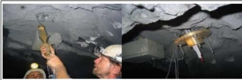
Figure 8-4: Exemple d'une surveillance du toit des galeries souterraines
