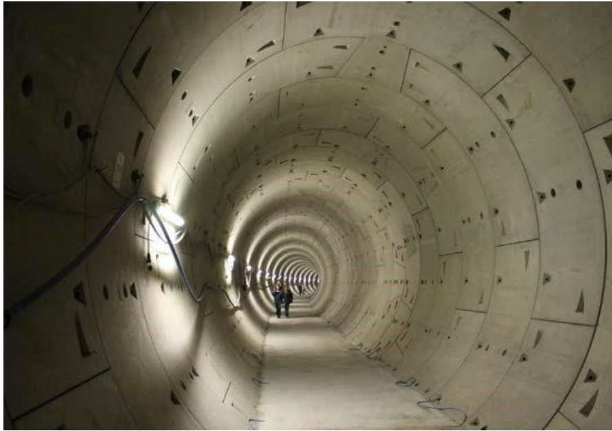
Figure II.10 : Application des voussoir sur chantier
