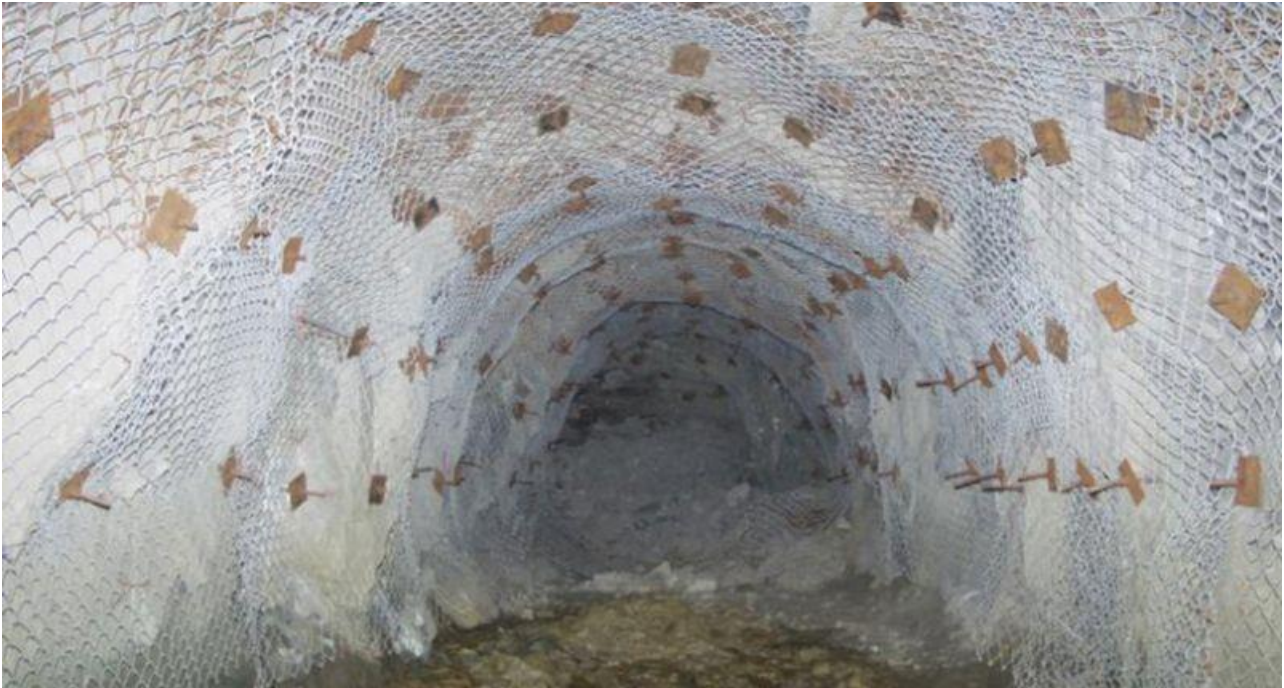
Figure II. 3 : exécution de boulon d' ancrage sur chantier
