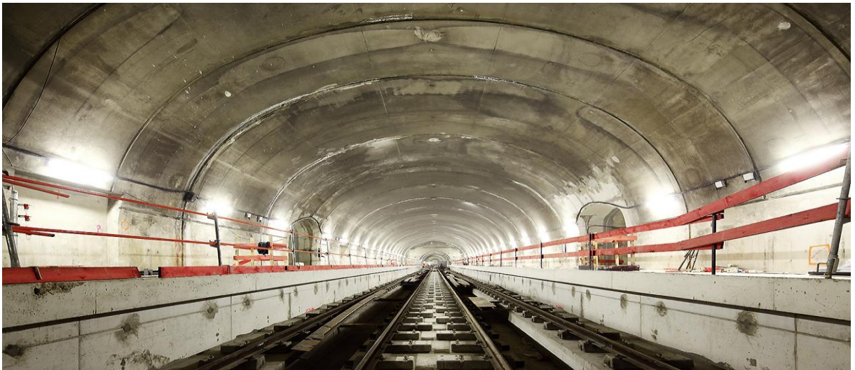
Figure I. 2: Photo de tunnel de métro en zone urbaine
