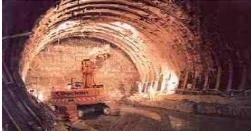
Figure I. 8: Creusement en pleine section
