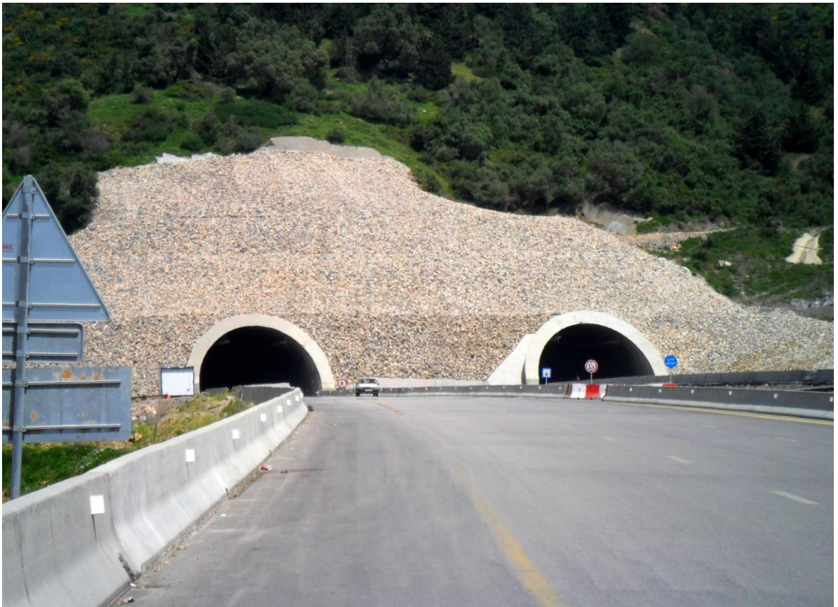
Figure I. 1:Photo de tunnel routier sous une montagne
