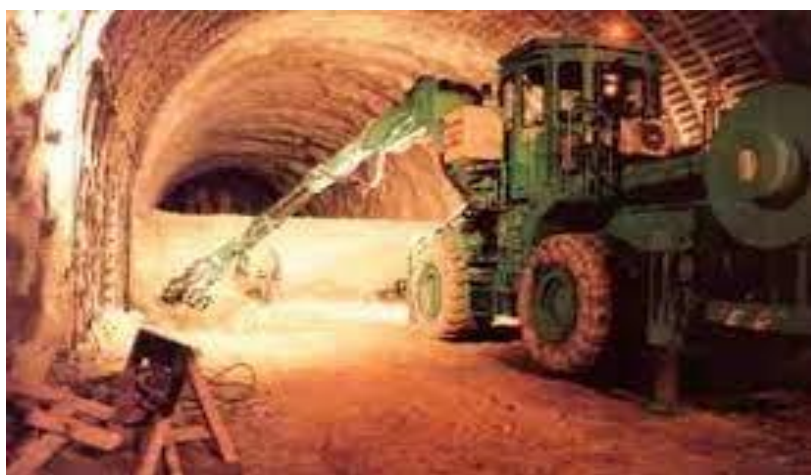
Figure I. 9: Creusement en demi-section.
