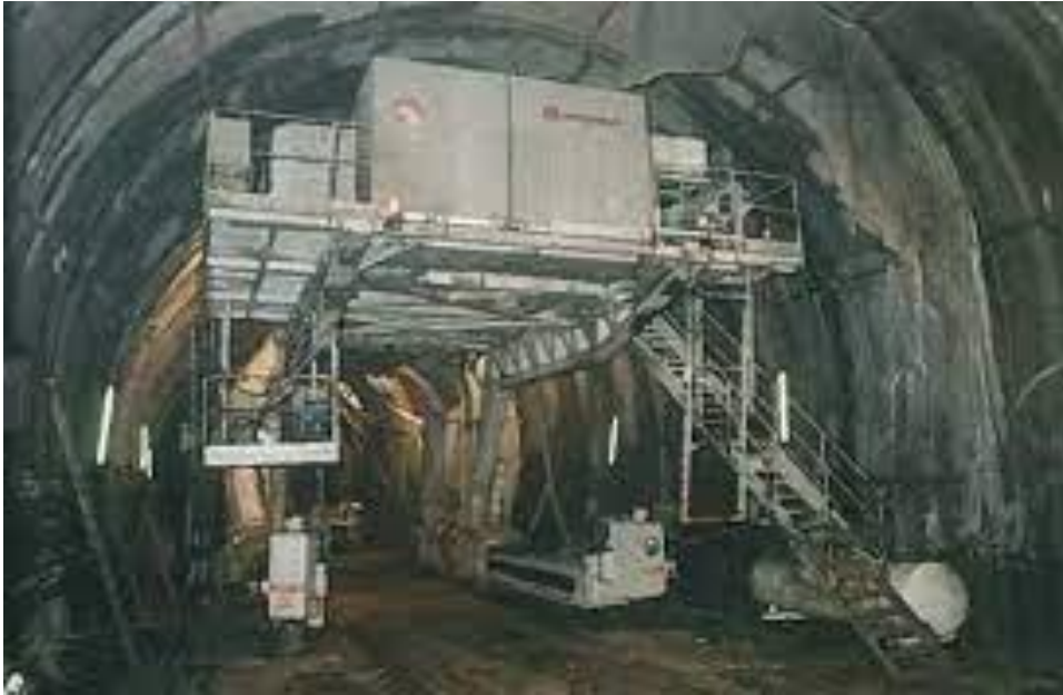
Figure I. 4: Machine pré-découpage mécanique
