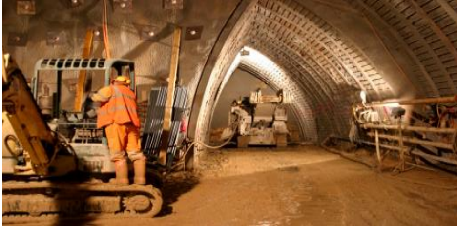
Figure I. 10: Creusement en section divisée
