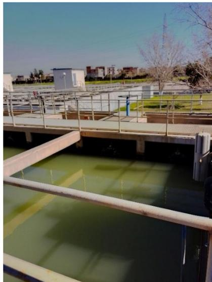
**Figure IV-6 :** Décanteur lamellaire
