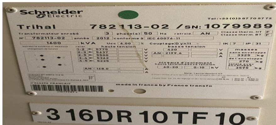
Figure IV. 7 Plaque signalétique du transformateur
