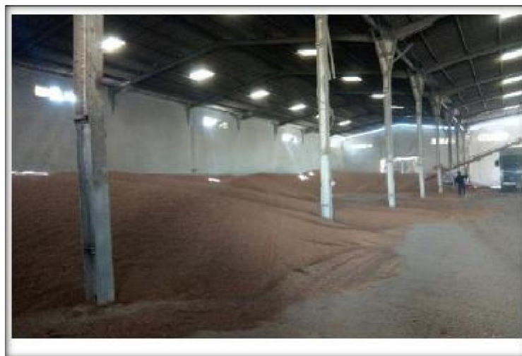
Figure 5. Bâtiment de stockage en vrac.
