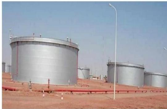
**Figure7 :** Réservoirs à toit flottant (Kardache et al, 2016)
