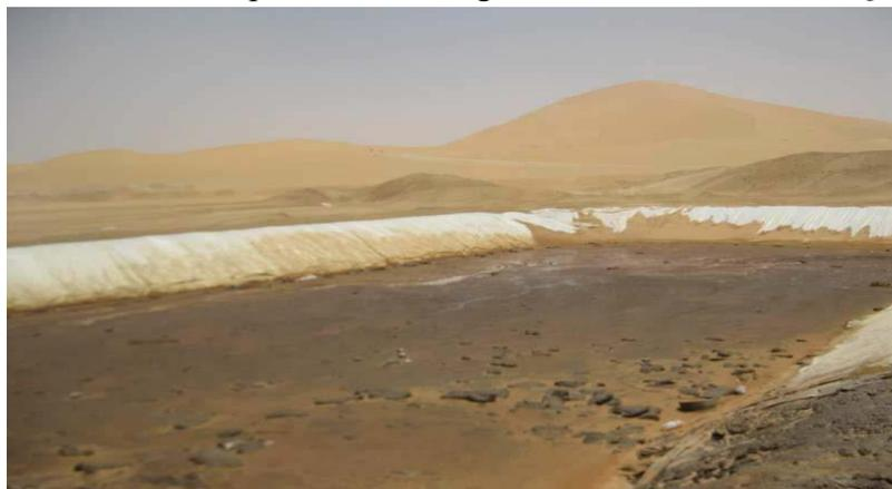
**Figure2** : Bourbiers après l'opération de forage à Hassi- Messaoud. (**Hadj Abbas, 2011**)
