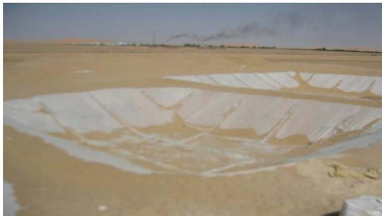
**Figure1** : Bourbiers avant l'opération de forage à Hassi-Messaoud (**Hadj Abbas, 2011**)
