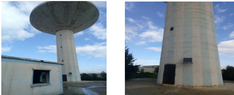
Figure 25 : Photo du château d'eau Hlaimia 1000\text{ m}^3 .
