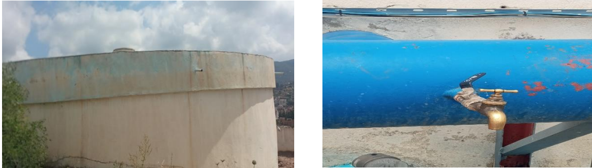
Figure 21 : Photo de réservoir Kherrouba 1000m 3 .
