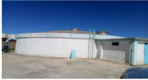
Figure 27 : Photo de station de pompage Boudouaou El Bahri.
