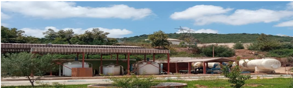
Figure 15 : Photo de la station de traitement monobloc Kharouba –Boudouaou.
