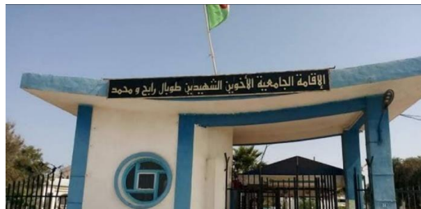
Figure 42 : Photo de la résidence de l'université de Boudouaou El Bahri.
