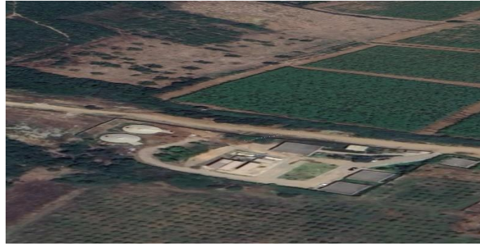
Figure 18 : Vu satellite de la station de traitement monobloc Kharouba –Boudouaou (GOOGLE MAPS 2023).
