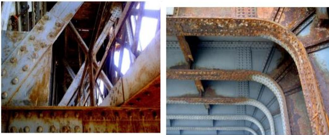
Figure I.5 : Corrosion uniforme des installations métalliques
