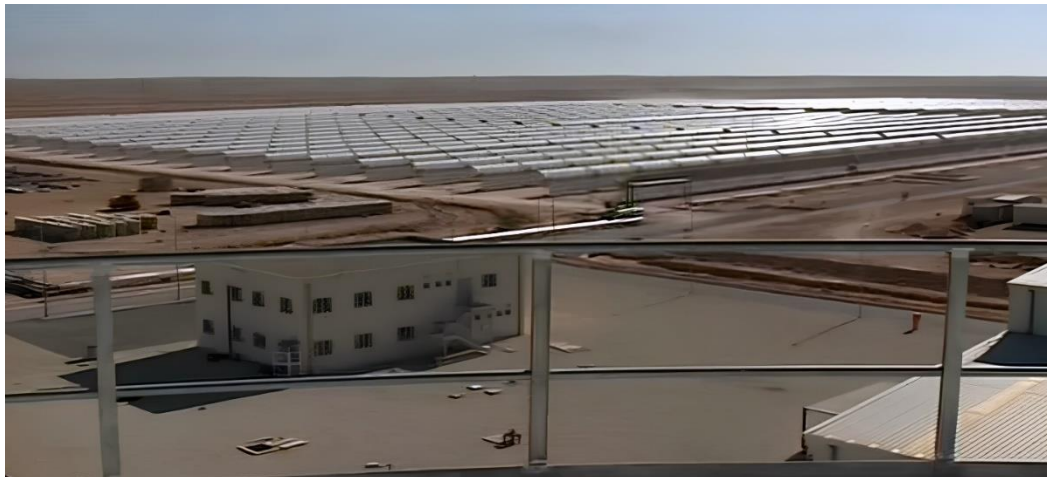
Figure 3 : L'une des premières centrales solaires hybrides au monde est située à Hassi R'Mel.
