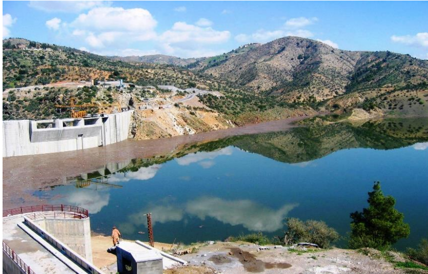
Figure 7 : Barrage de kherrata w de bejaia
