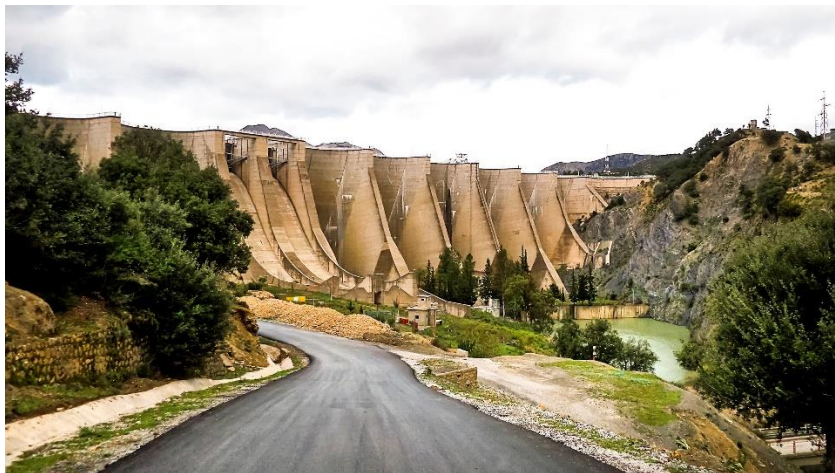
Figure 8 : Barrage de Erraguene اراقن سد
