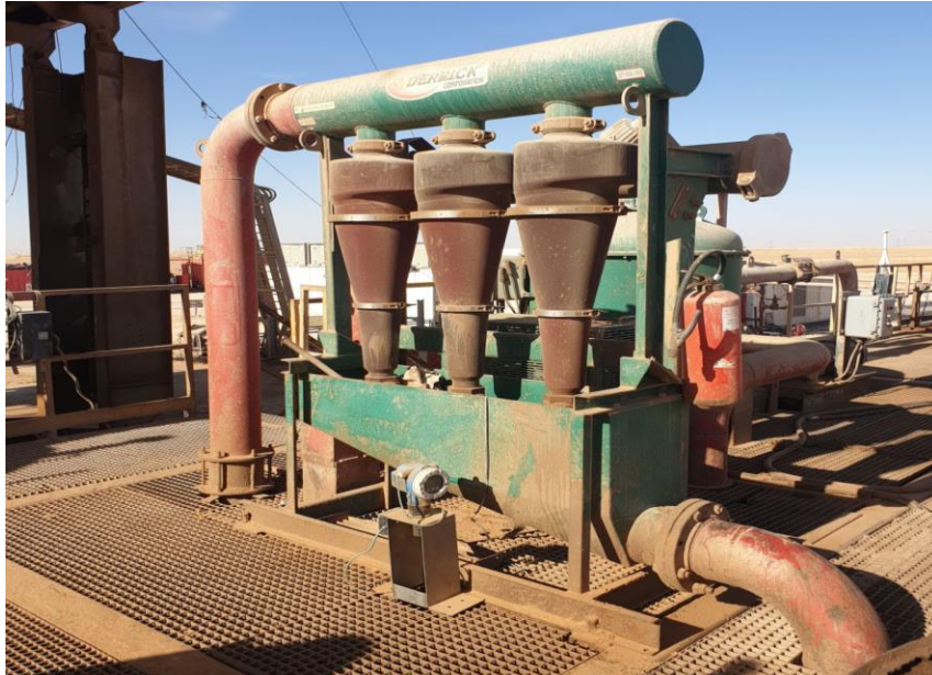
Figure 1.7 : Dessableur de marque derrick de RIG ENF#61.
