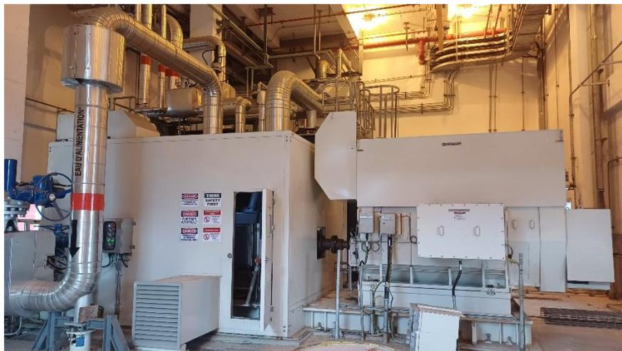
Figure 2. 10 : Pompe alimentation chaudière
