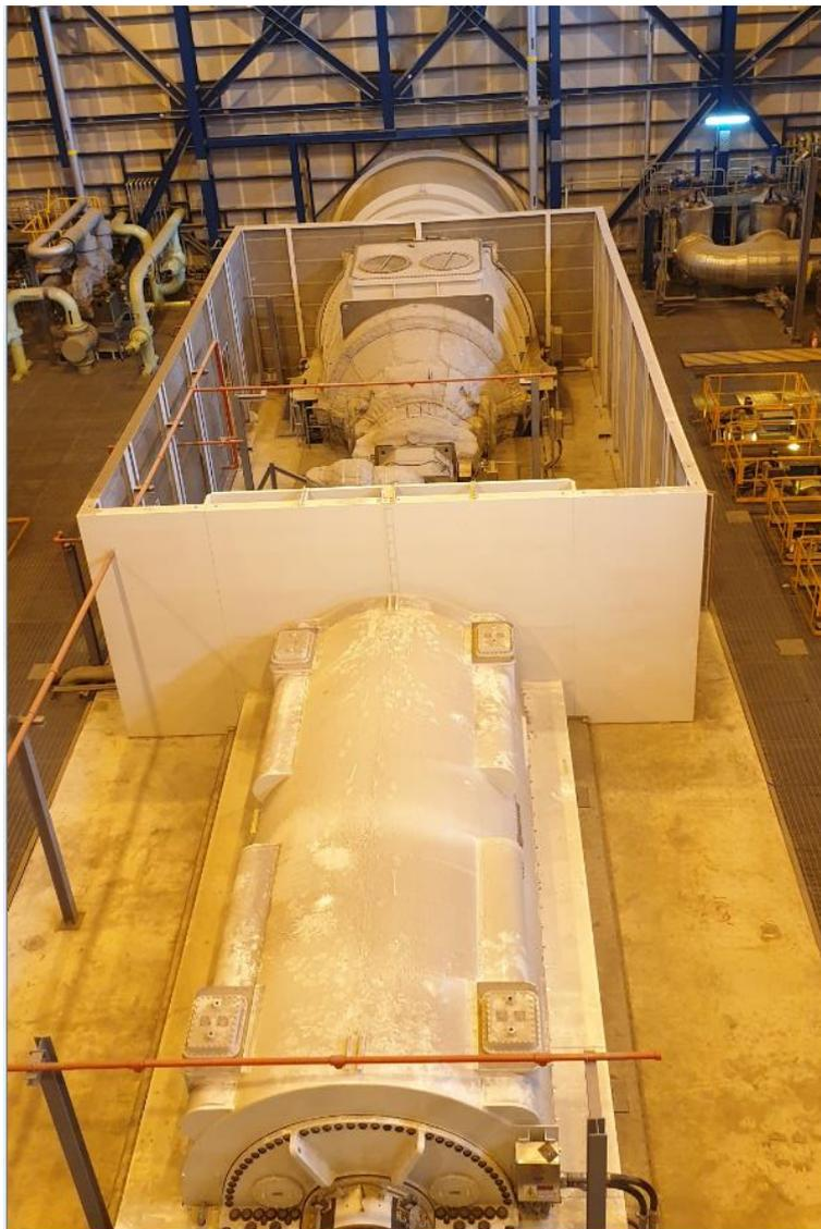
Figure 2. 5 : Turbine à vapeur et le générateur.
