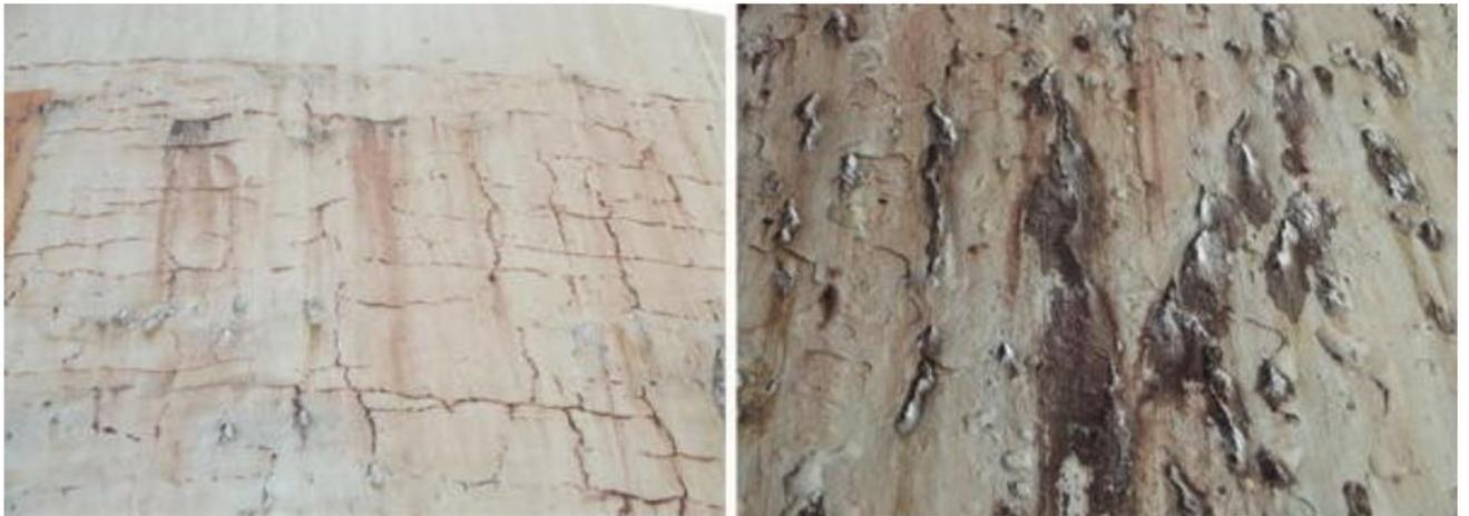
**Figure 2.2** Détails de fissuration sur la paroi du réservoir
