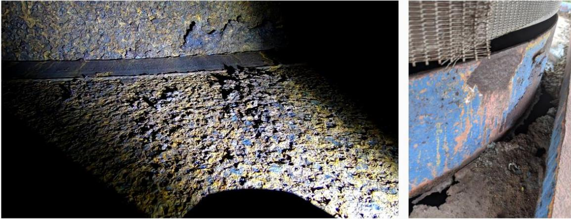
Figure 2.1 Corrosion interne de robe et d'un toit de bac
