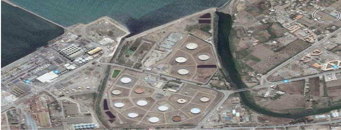
Figure I. 4 : Terminaux de RTC.
