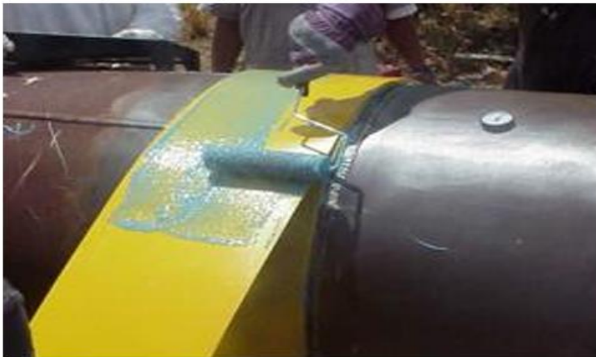
Figure VI.4.3 : Application de la résine sur les feuilles du CLOCK SPRING.
