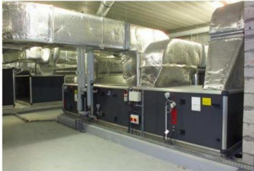
Figure III.12: Station de traitement d'air.
