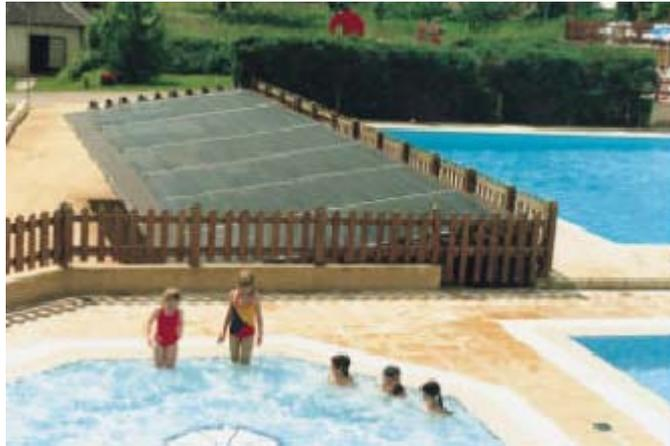
Figure I.2 Capteur Sans Vitrage [16]
