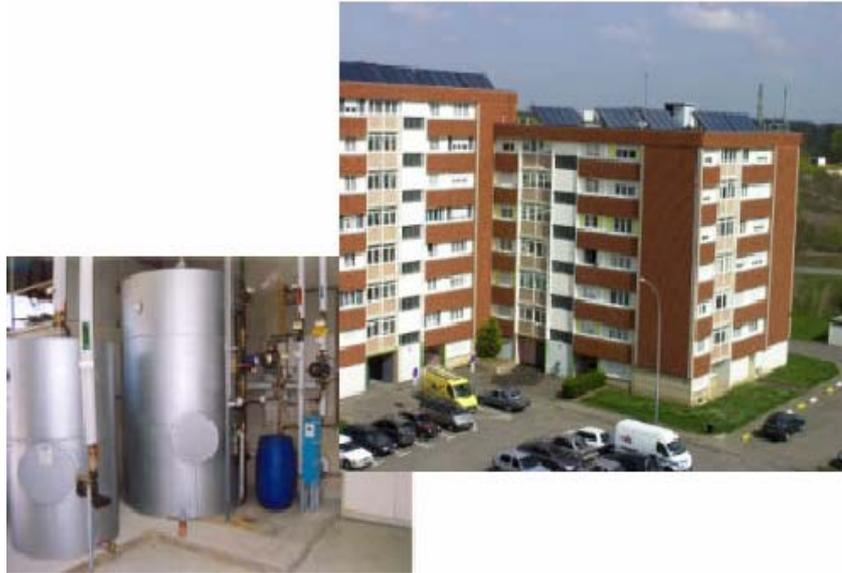
Figure IV.4 Installation de production d'eau chaude de STRASBOURG
