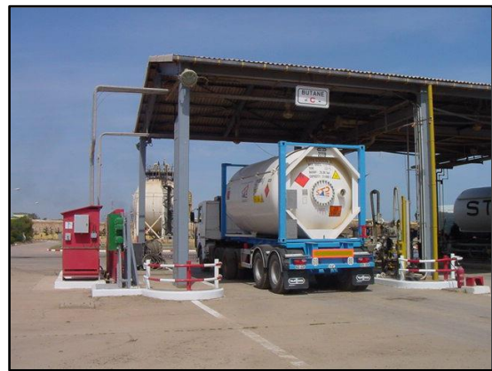
Figure I-19 : Rampe de chargement de camion du GP1/Z.
