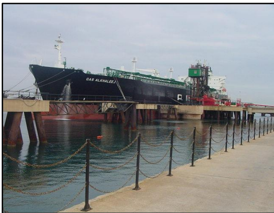
Figure I-18 : Quai de chargement de navire du GP1/Z.
