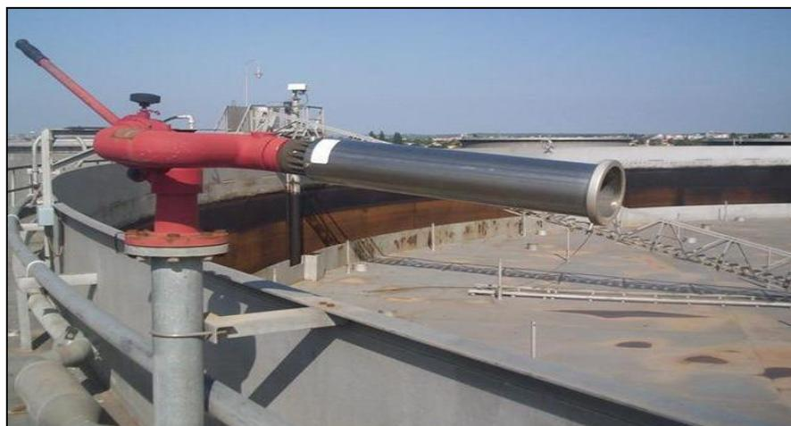
Figure 7.2-3: Protection d'un bac par lance monitors fixé en haut de la robe [25]
