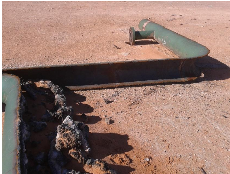
Figure N°II.4: Sulfate de baryum à l'intérieur du tubing.
