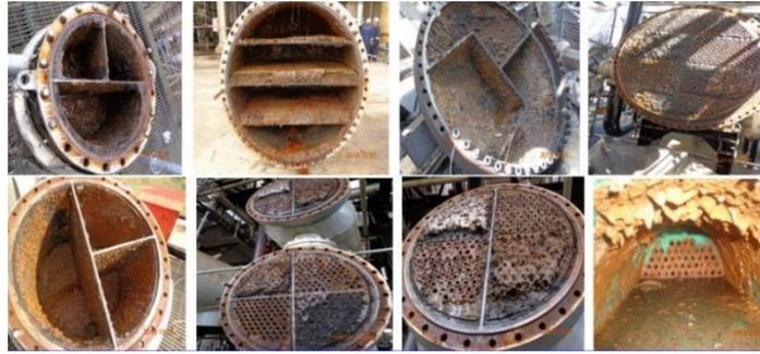
Figure 2.12 : Encrassement des refroidisseurs à eau du complexe RA2K
