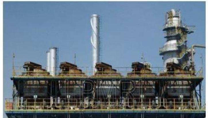
*Figure 3.20: Vue générale d'un ensemble des aéroréfrigérants*
