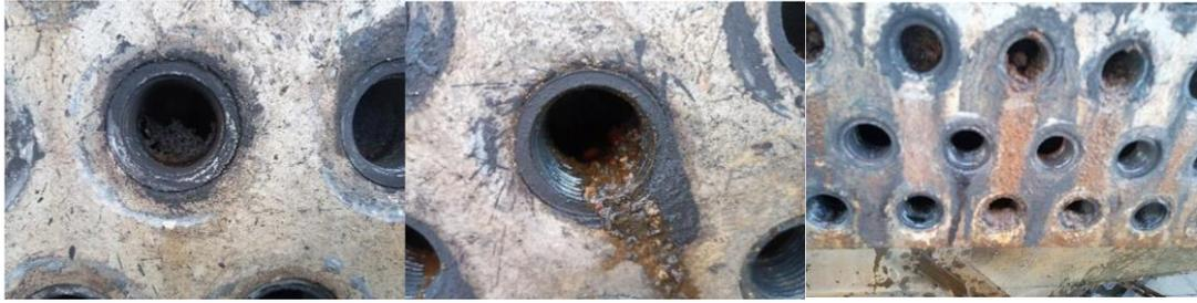
Figure 4.3 : La présence de dépôt solide au niveau de quelques tubes de l'aéroréfrigérant 100-AM-101
