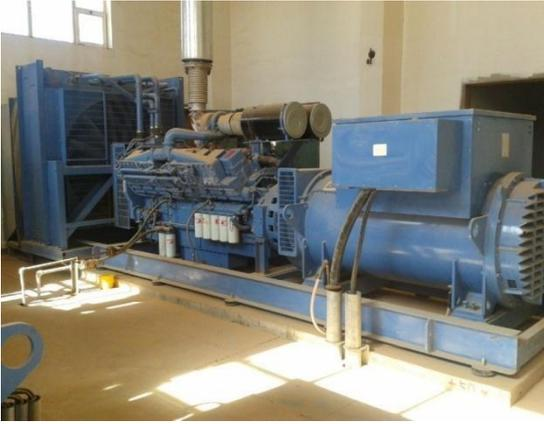
**Figure I-11 Générateur turbo-diesel.**
