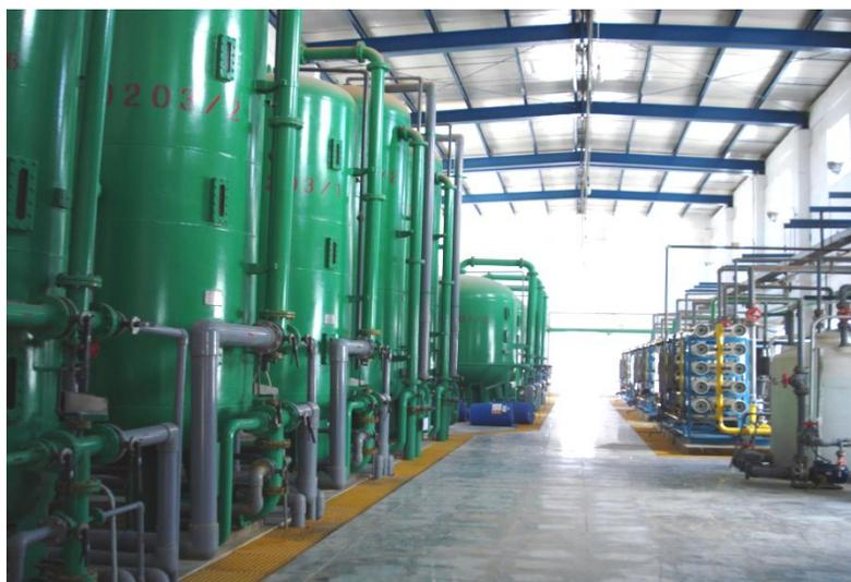
**Figure I-6 La batterie d'osmose inverse.**
