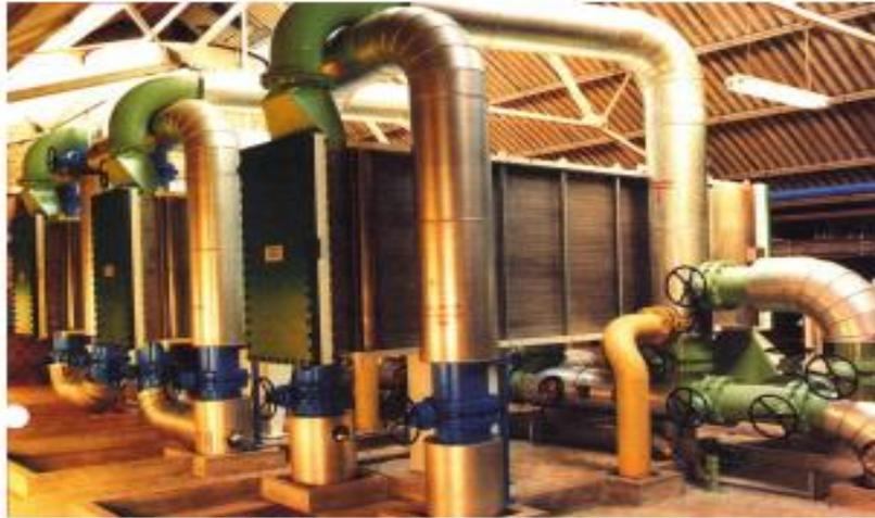
Figure VI. 5: Exemple d'un échangeur à plaques
