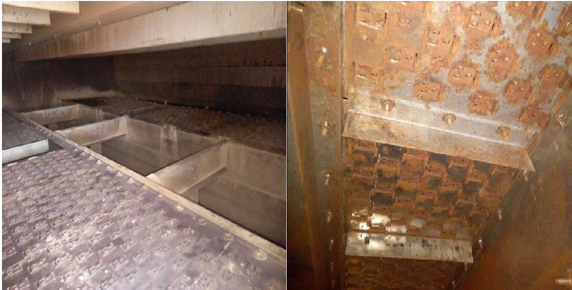
Figure 3-8 : Aperçu d'un plateau de la colonne préfractionnement Four RA2/K
