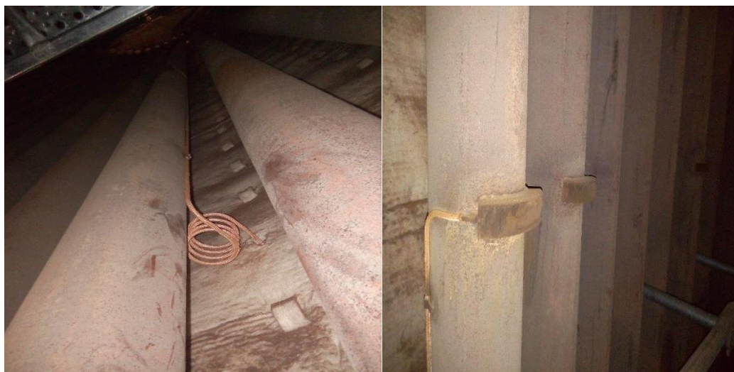
Figure 3-18 : Thermocouple de peau sur un tube de la zone de radiation Four RA2/K
