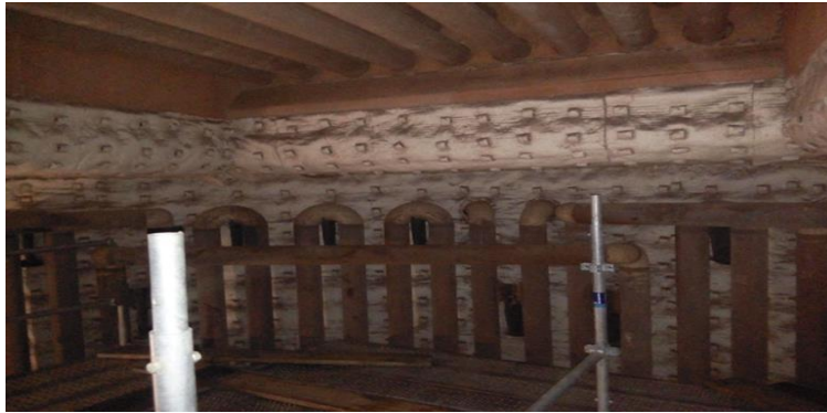
Figure 3-11 : Rampe de décharge Four RA2/K
