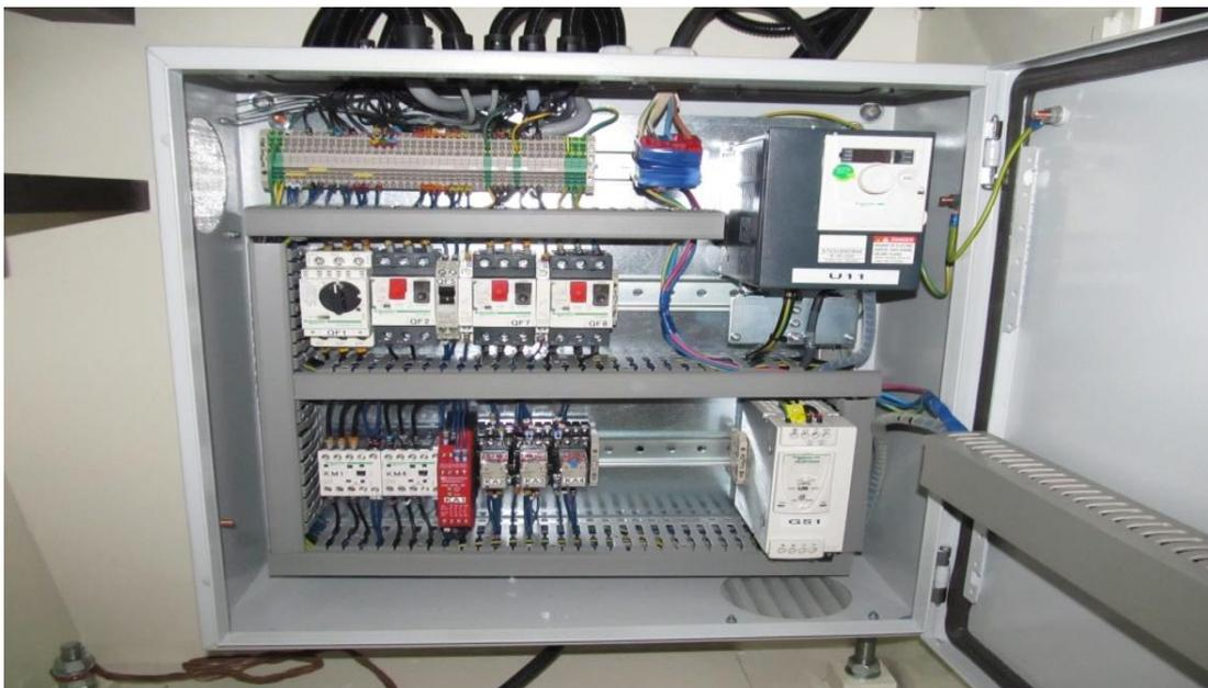
Figure II.13:Armoire de commande
