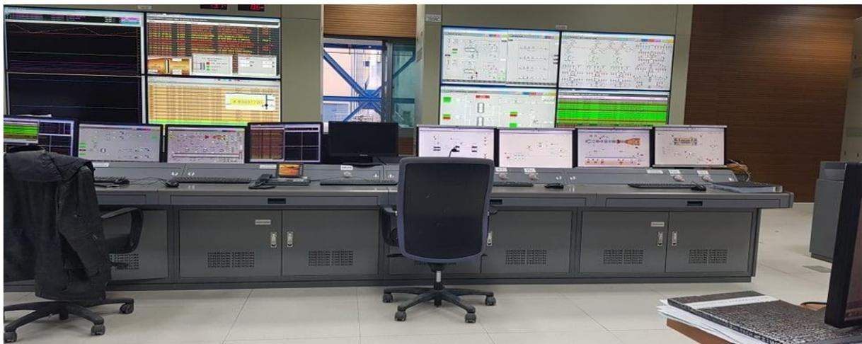
**Figure I 15** Salle de commande de la centrale à cycle combiné Ras-djinet
