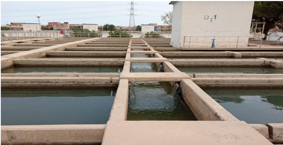
**Figure IV. 5 : Décanteur pulsateur**
