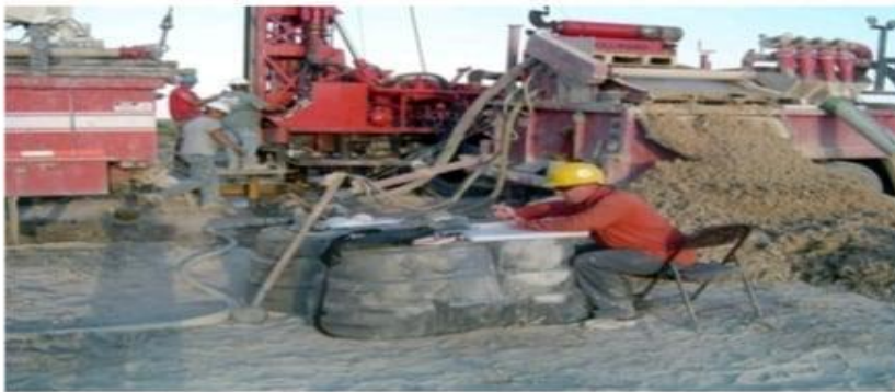
Figure 7 : traitement biologique du bourbier
