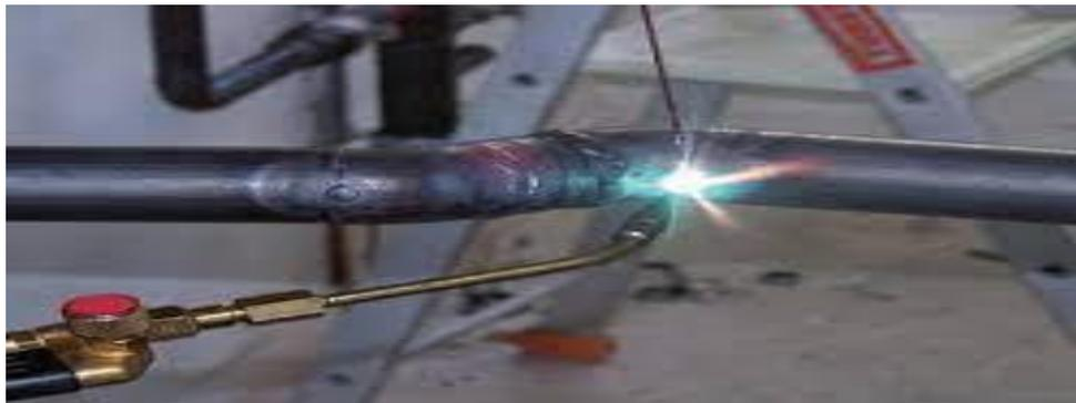
Figure II.18: Soudage au chalumeau
