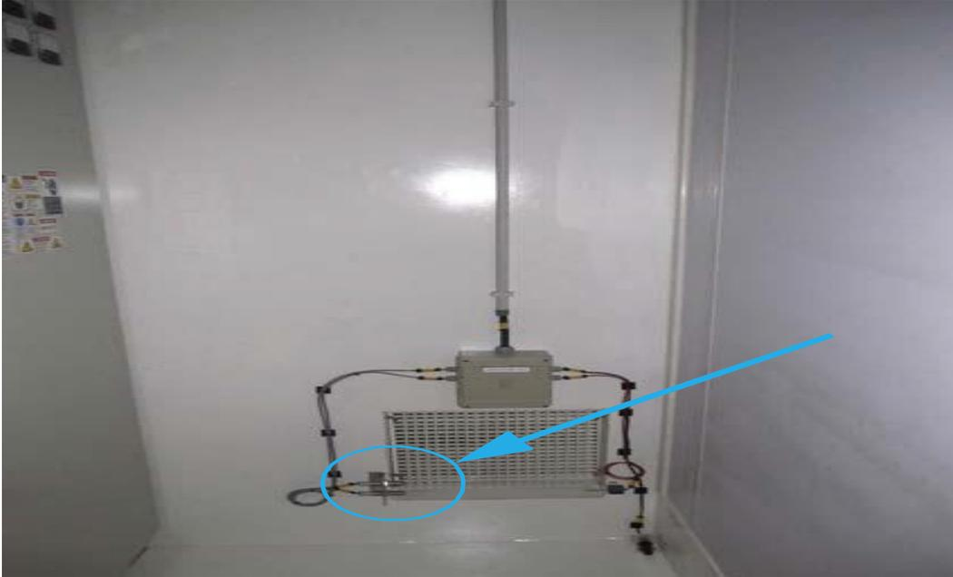
Figure III.15. Contrôle du fonctionnement du contacteur décimétrique d'air. [12]
