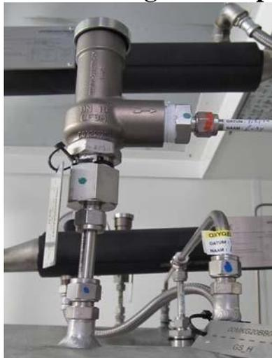
Figure III.10. Soupape de sécurité
