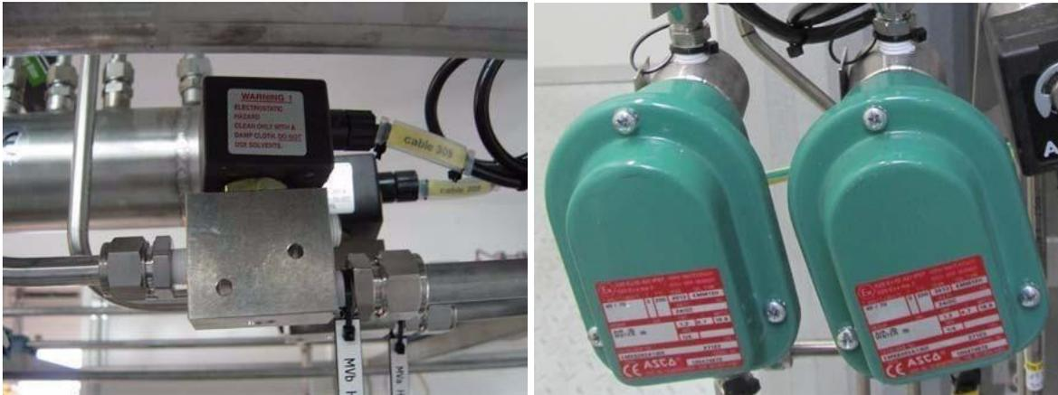
Figure III.13. Remplacement de l'électrovanne
