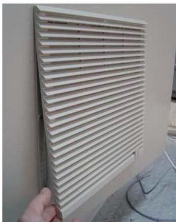
Figure III.1. Démontage des couvercles du filtre
