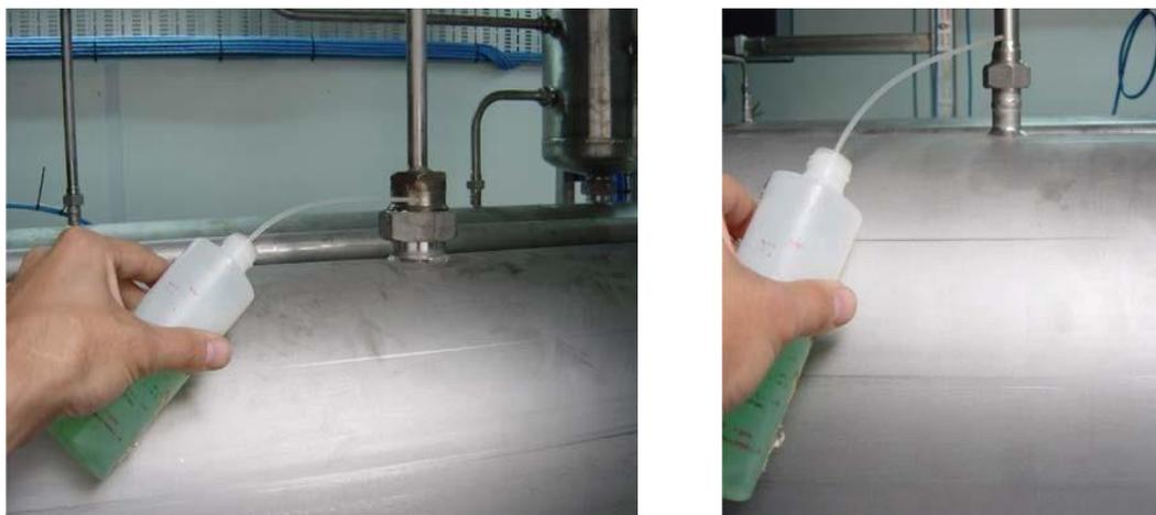
Figure III.3. Contrôle des fuites de gaz avec une solution savonneuse
