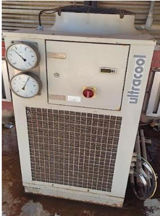
Figure II.16. Refroidisseur de l'électrolyte et du compresseur
