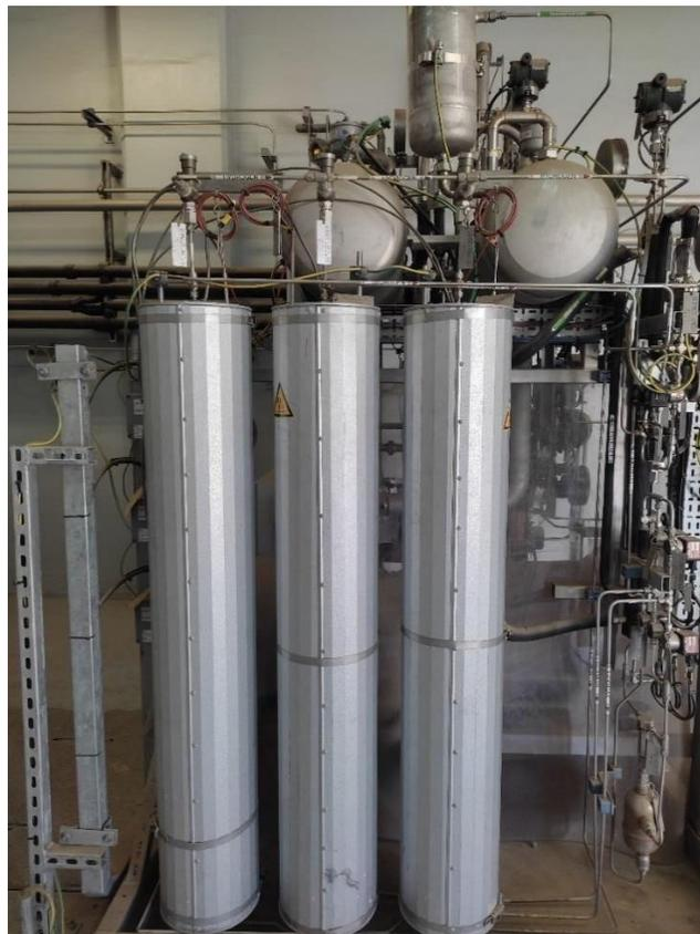
**Figure III.8.** Transmetteurs de température (PT100) : Deoxo (à gauche), sécheur A (au milieu) et sécheur B (à droite).
