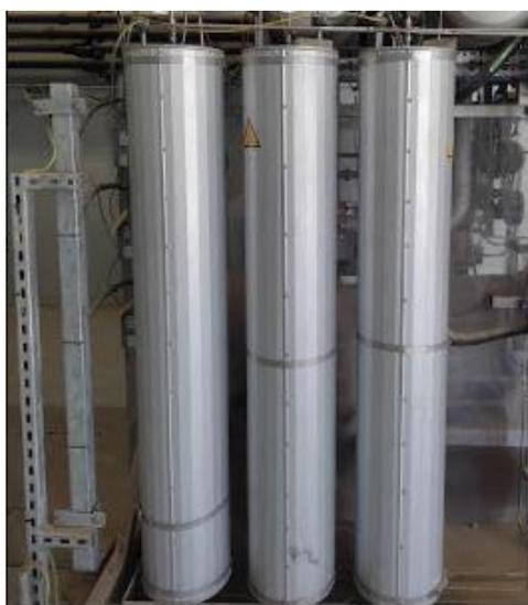
**Figure II.14.** Sécheur Deoxo
