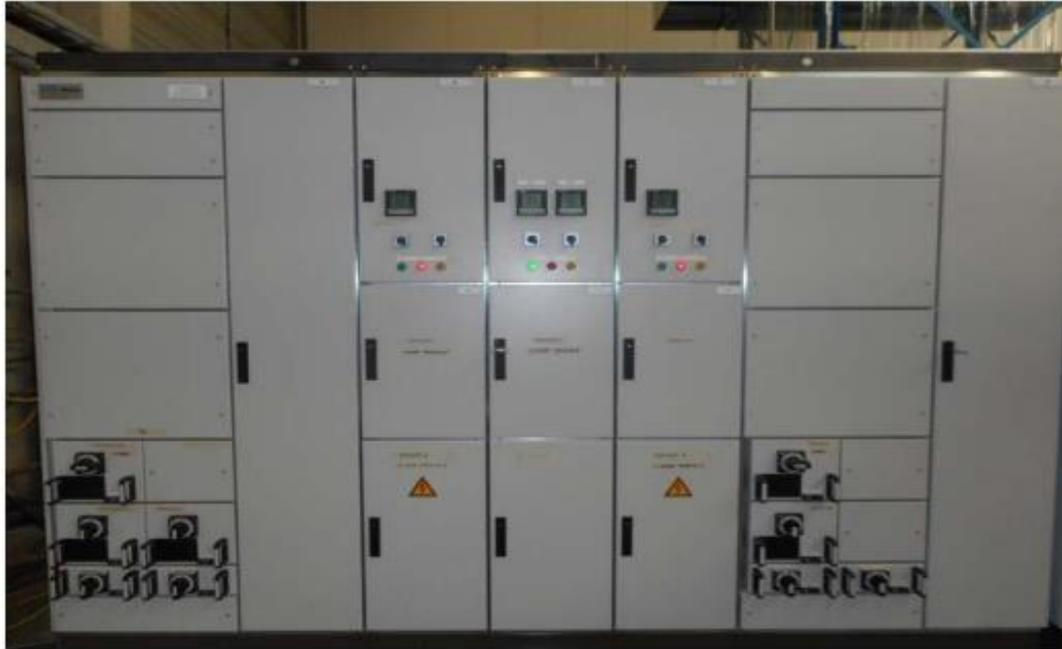
Figure II.17. Le centre de commande du moteur (MCC)
