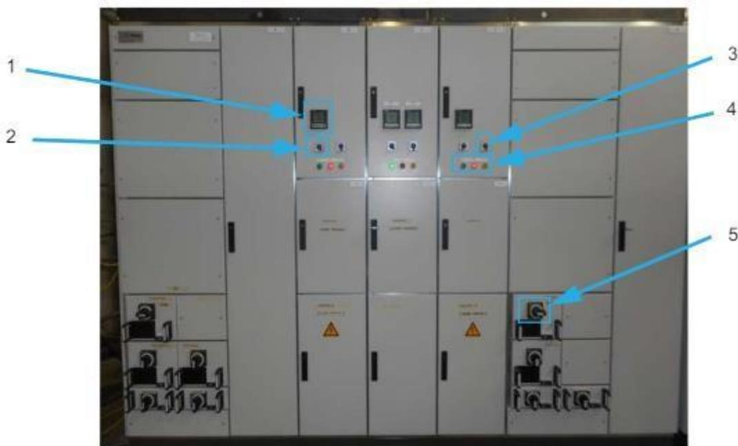
Figure II.21. Interface du centre de commande du moteur : voyants et commutateurs
