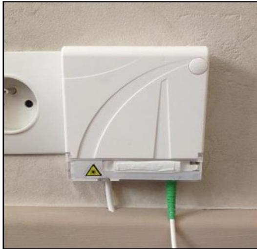
**Figure II. 13 POT (Prise Terminal Optique) [15] [23]**
