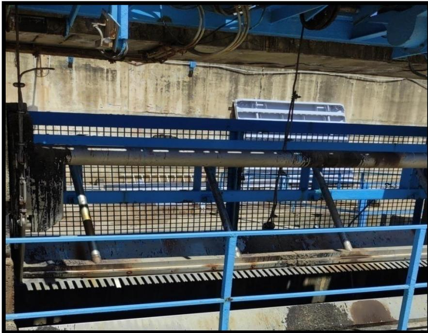
**Image 01: dégrilleur électriquement**
