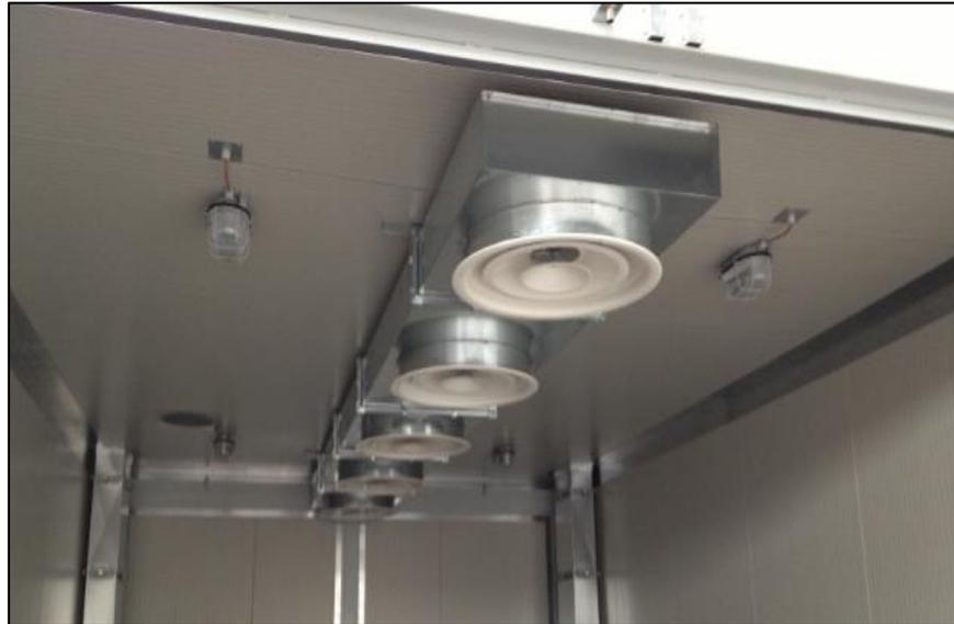
**Figure II.1 :** Système de ventilation d'une cabine peinture.
