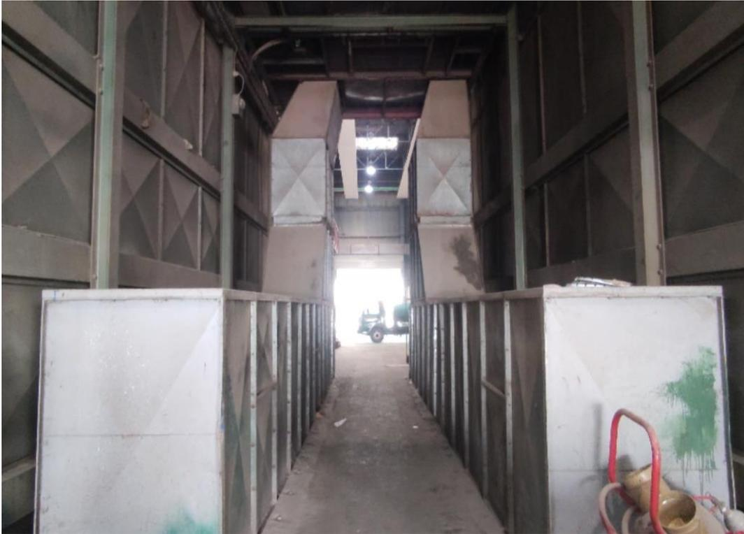
**Figure III.6 :** Les Canales d'extraction de la cabine de peinture humide.
