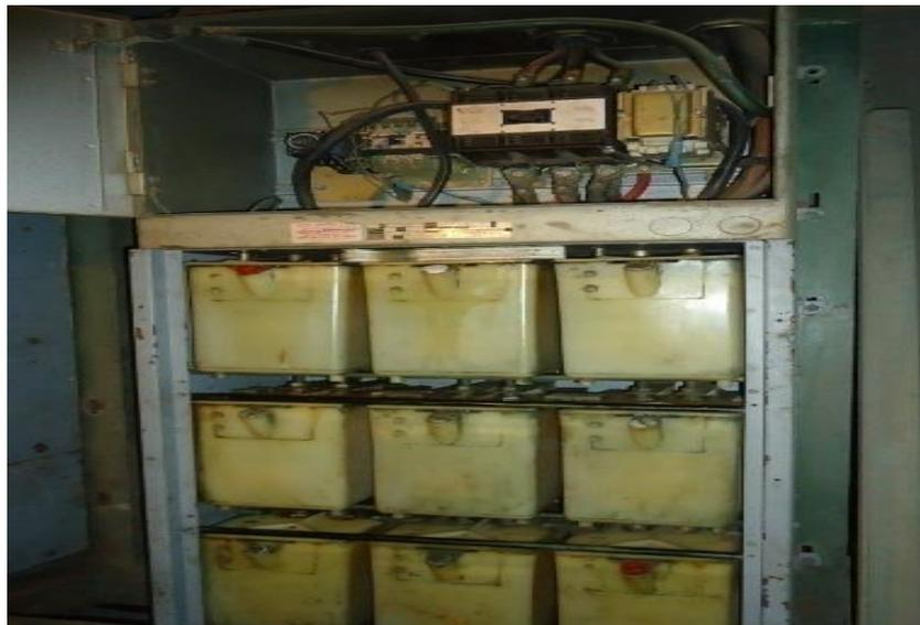
**Figure V.4 :** Démarreur électrolytique d'un moteur de soufflage dans la cabine de peinture.
