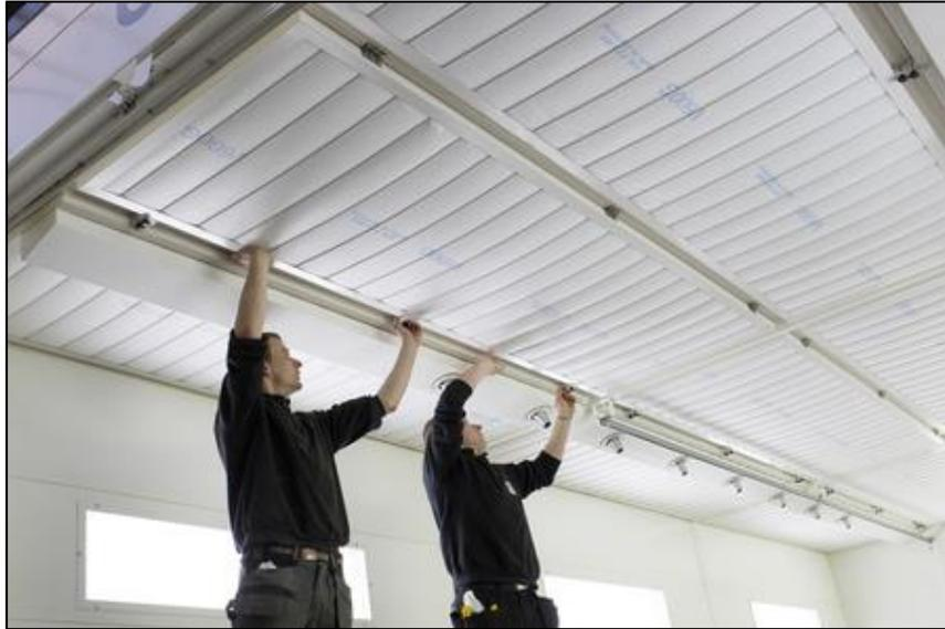
**Figure II.2 :** Un filtre d'une cabine peinture.
