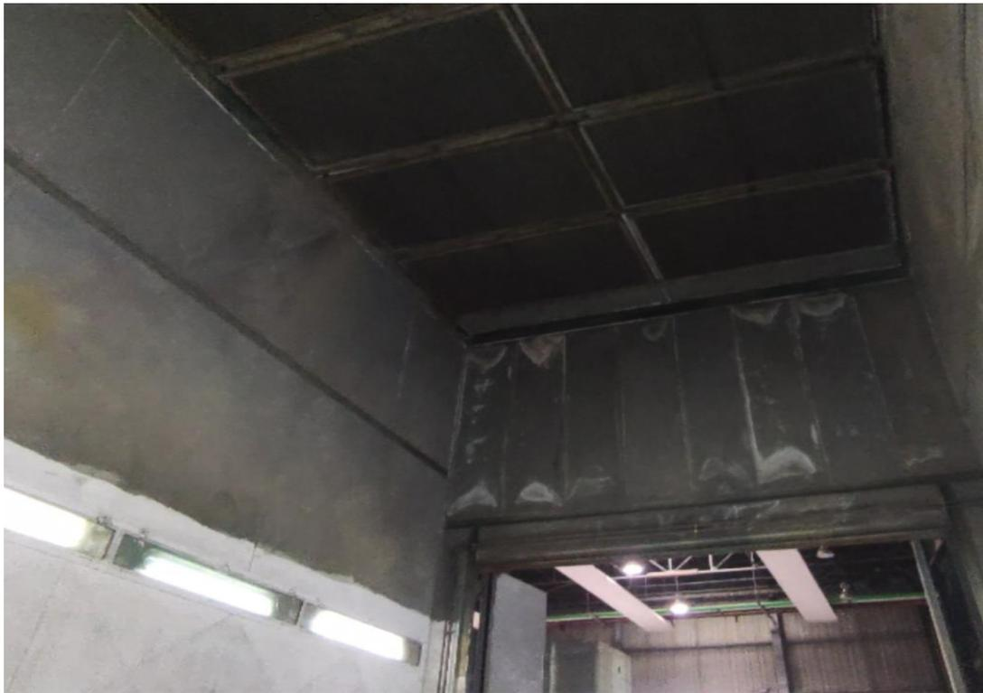
**Figure III.5 :** Les filtres déposés au plafond de la cabine de peinture humide.
