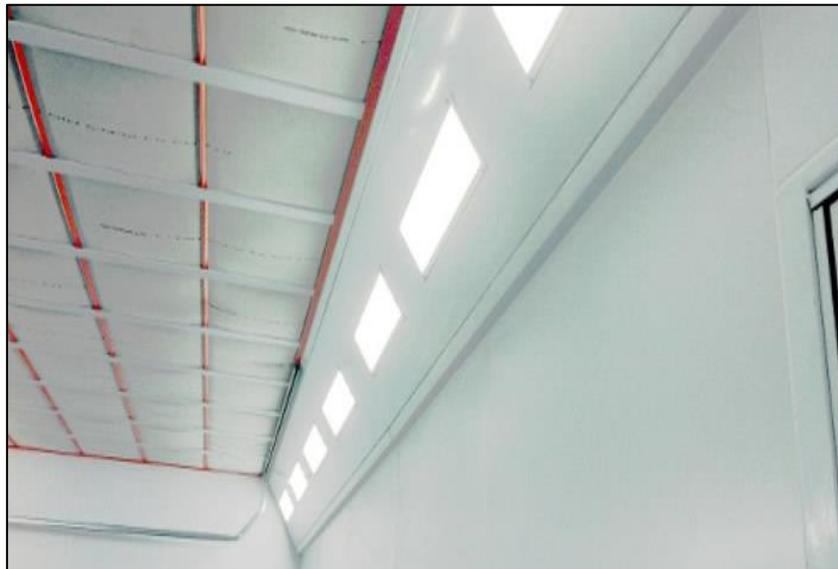
**Figure II.3 :** éclairage d'une cabine peinture.
