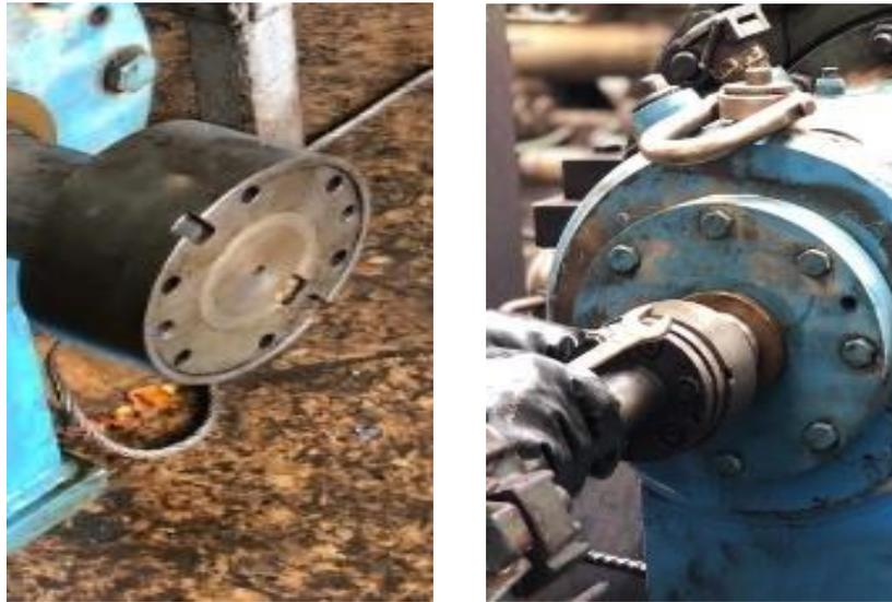
**Figure IV.13 : Accouplement de pompe P025 avant et après le montage.**
