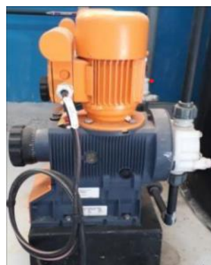
Figure II-4 : Pompe doseuse [18].
