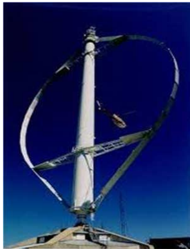
FigureI.6 : Eolienne à rotor Darrieus.
