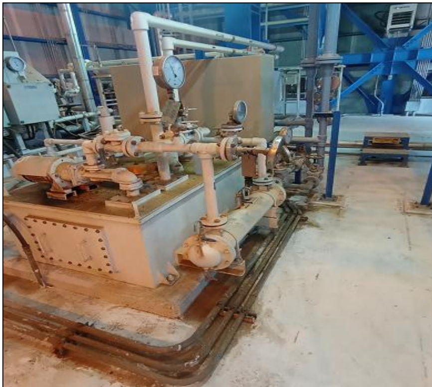
Figure III 12 Système d'huile de lubrification
