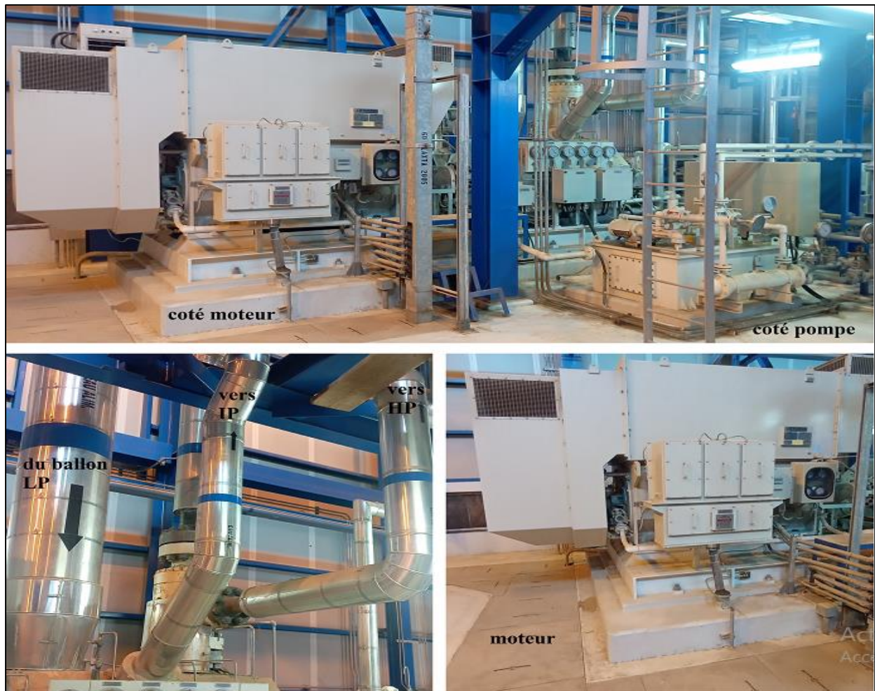
Figure III 2 Composants de la pompe alimentaire
