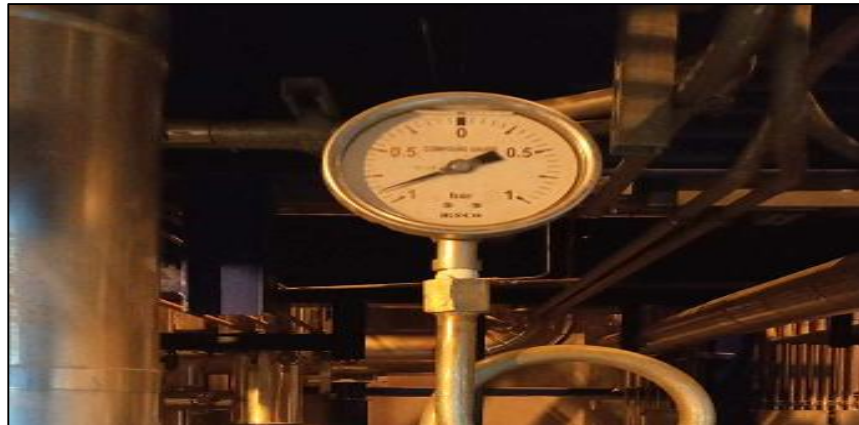
Figure III 20 Indicateur de pression de type bourdon
