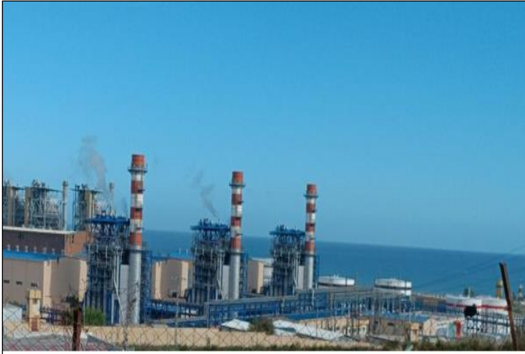
Figure I 2 Vue externe de la centrale à CC RAS-DJINET [2].
