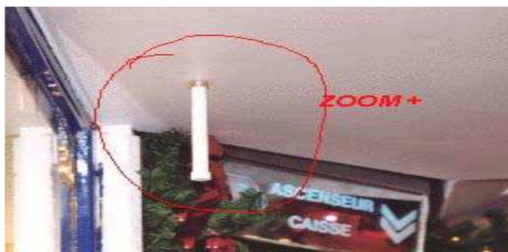
FIGURE 2.9 : Antenne omnidirectionnelle pour micro cellule dans une galerie commerciale
