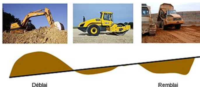
FIGURE 2.12 : Déblais mis en remblais
