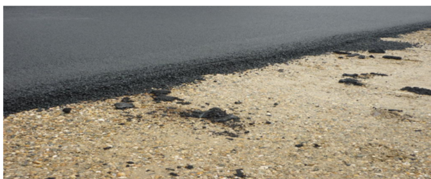
FIGURE 2.13 : Revêtement en enrobe
