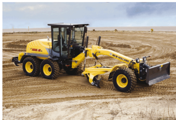
FIGURE 2.9 : Opération de terrassement
