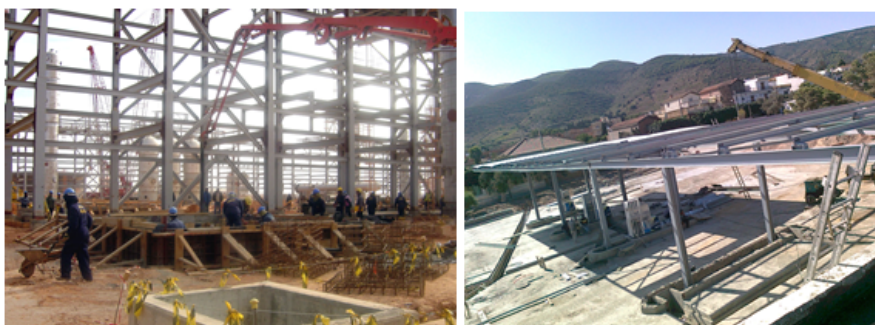
FIGURE 1.10 : Fabrication et Construction métallique
