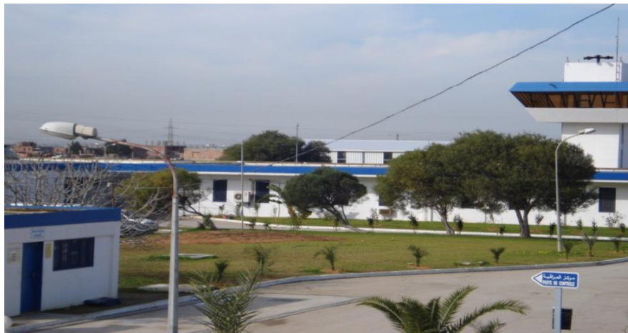
Figure II.7 : Centre de Traitement Eau potable BOUDOUAOU
