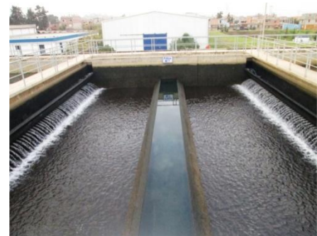
Figure II.6.b. Filtres en phase de remplissage
