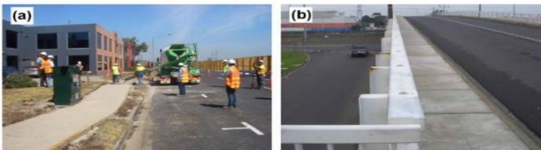
Figure I.9 : E-Crete TM dans un port à Melbourne, Australie: a) 25MPa trottoir à travers de Westgate Freeway extension. b) 55MPa panneaux préfabriqués à travers du pont Salmon Street. (J. S. J. Van Deventer et al, 2012)
