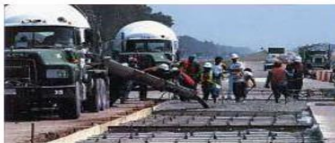
Figure I. 1: Renovation des routes avec Pyrament®
