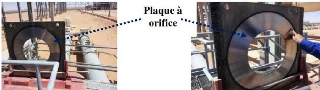
*Figure V. 4 : Plaque à Orifice du site GTFT [20].*
