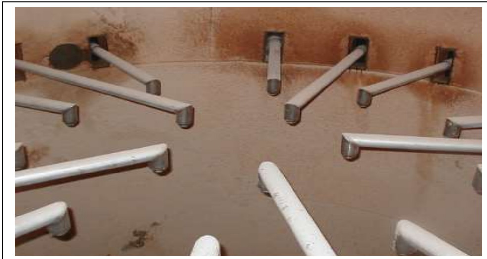
Figure 2.4 Position des buses à l'intérieur de la GCT
