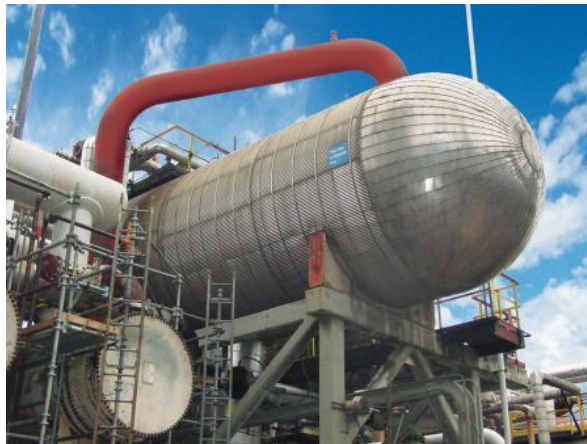
Figure 2.12 - Vue externe d'un rebouilleur [26]
