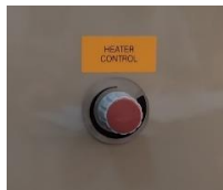
Figure 3.9 – La commande du réchauffeur
