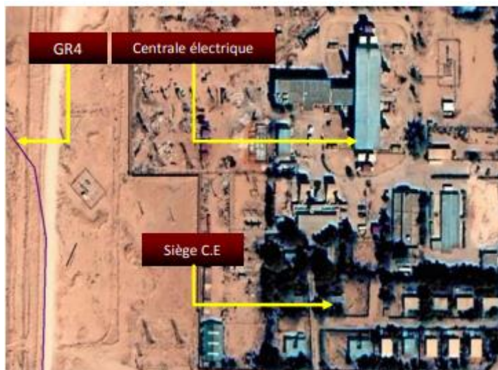
Figure III-4: Elément sensible 04 et 05 – Centrale électrique
