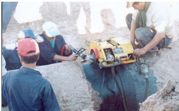
Figure VI.5 : Début de coupe : réglage de la vitesse de la machine.
