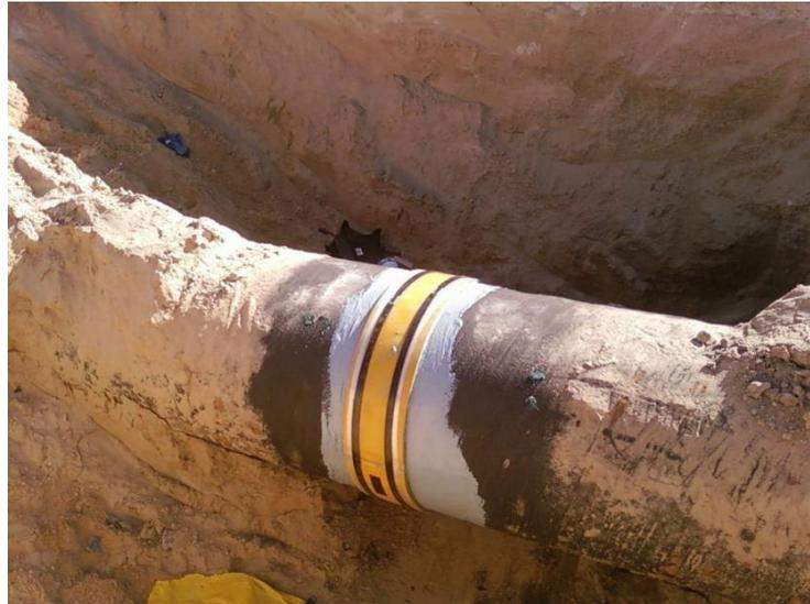
*Figure VI.9 : Réparation par CLOCK SPRING finie*
