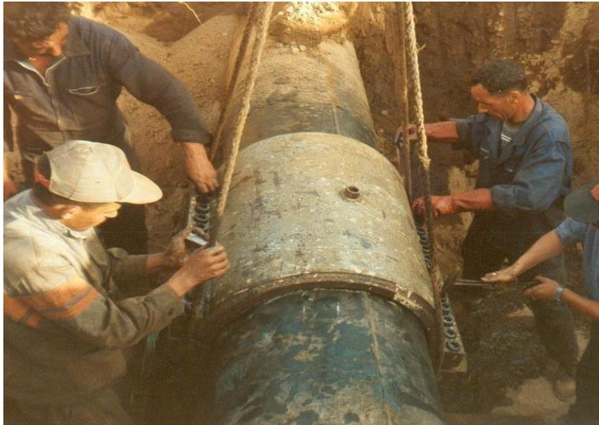
*Figure VI.7 : mise en place et serrage du split + sleeve*
