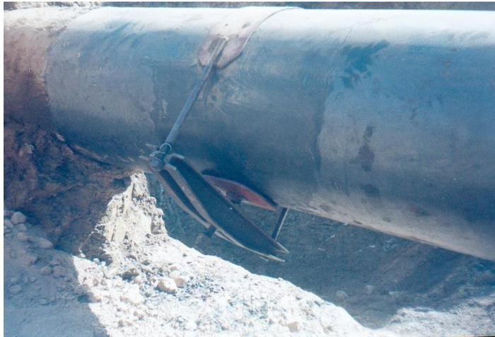
*Figure VI.11 : fuite étanchée par la pose d'une rustine maintenue par un collier*
