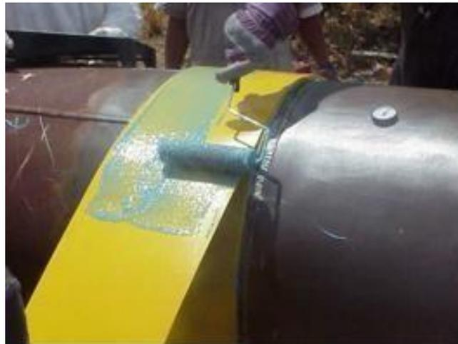
*Figure VI.8 : Application de la résine sur les feuilles du CLOCK SPRING.*
