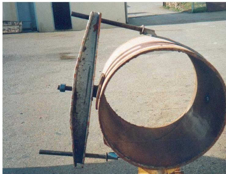
*Figure VI.10 : Rustine maintenue par un collier sur une canalisation*
